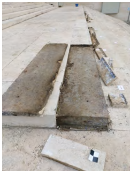
Rimozione della prima lastra di travertino dello scalone e riposizionamento nel sito originario Foto di Giovanni Dibenedetto
