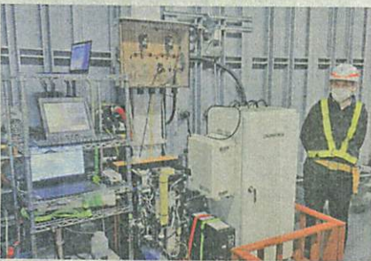
東京スカイツリーの458階地点に設置された観測装置と三隅良平さん＝東京都墨田区
